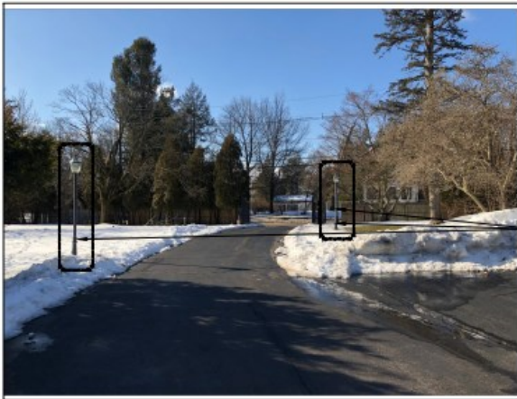
① EXISTING MAIN ENTRANCE N.T.S.
